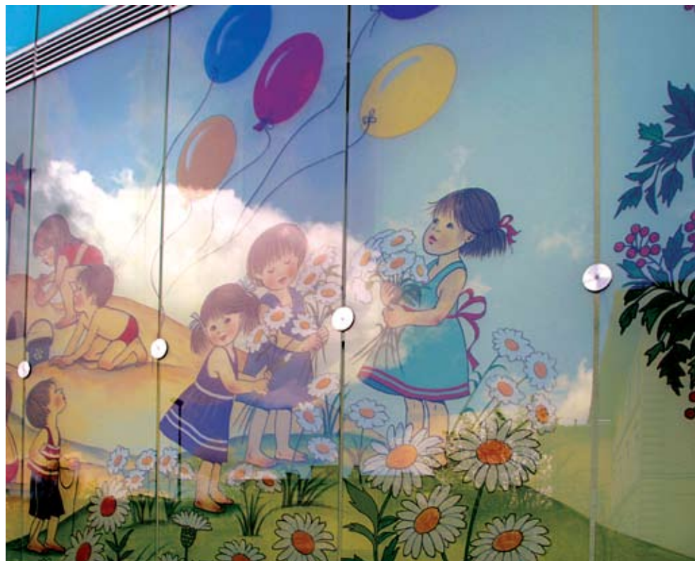
Poletje, detajl pročelja Pediatrične klinike
